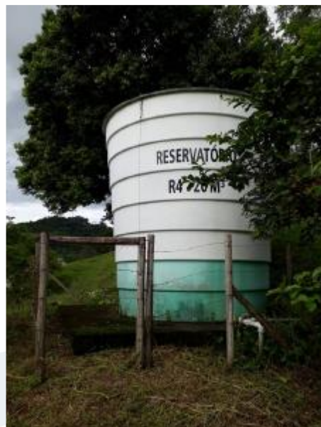
Figura 85 - Localização do Reservatório R04 – 20m 3
