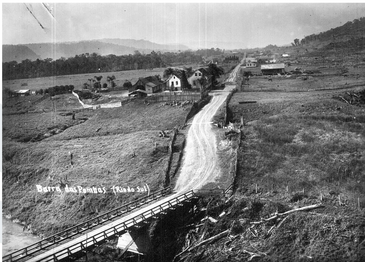
Figura 96 – Picada Transformada em Estrada Carroçável na Colônia de Rio do Sul.
