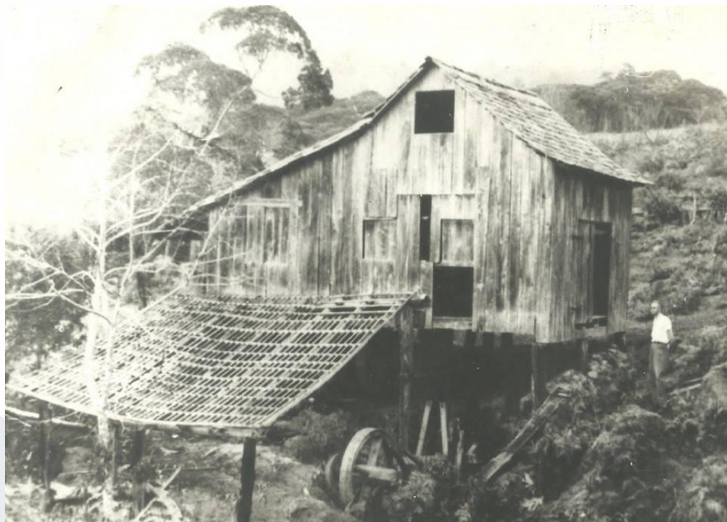
Figura 101 – Atafona Utilizando a Água como Força Motriz.
