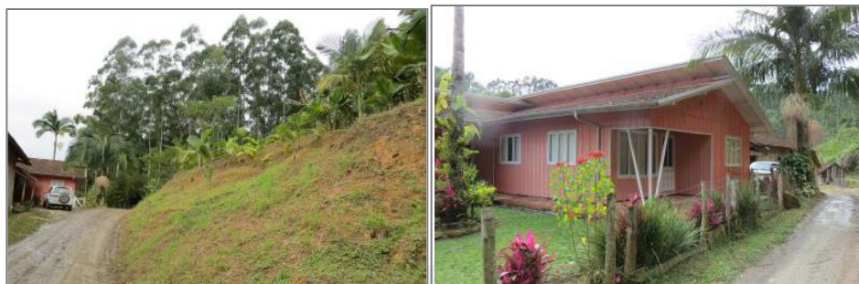
Figura 58 e Figura 59 - Setor de Risco 01, identificado na Localidade de Rio Herta.
