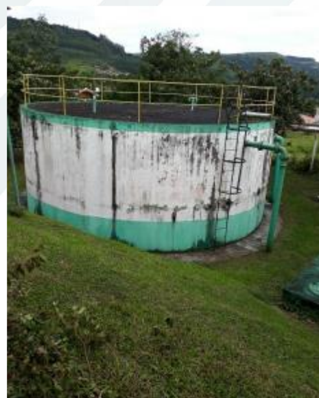
Figura 83 - Localização do Reservatório R02 – 250m 3
