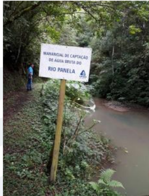
Figura 79 – Cercamento do Ponto de Captação de Água no Rio Panela
