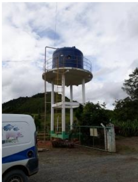
Figura 84 – Localização do Reservatório R03 – 20m 3
