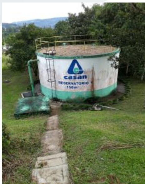
Figura 82 – Localização do Reservatório R01 – 150m 3
